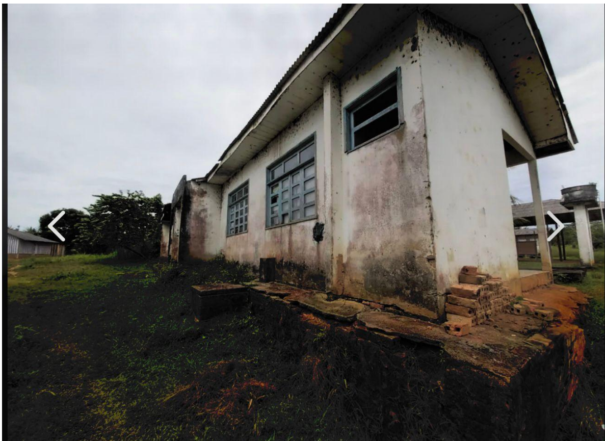
Figura 1: Parte externa da Escola com Paredes completamente desgastadas e morfadas, sem janelas; Fonte: Folha bv.
