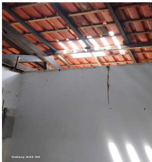
Foto 02: Telhado do hospital. Fonte: Autor
