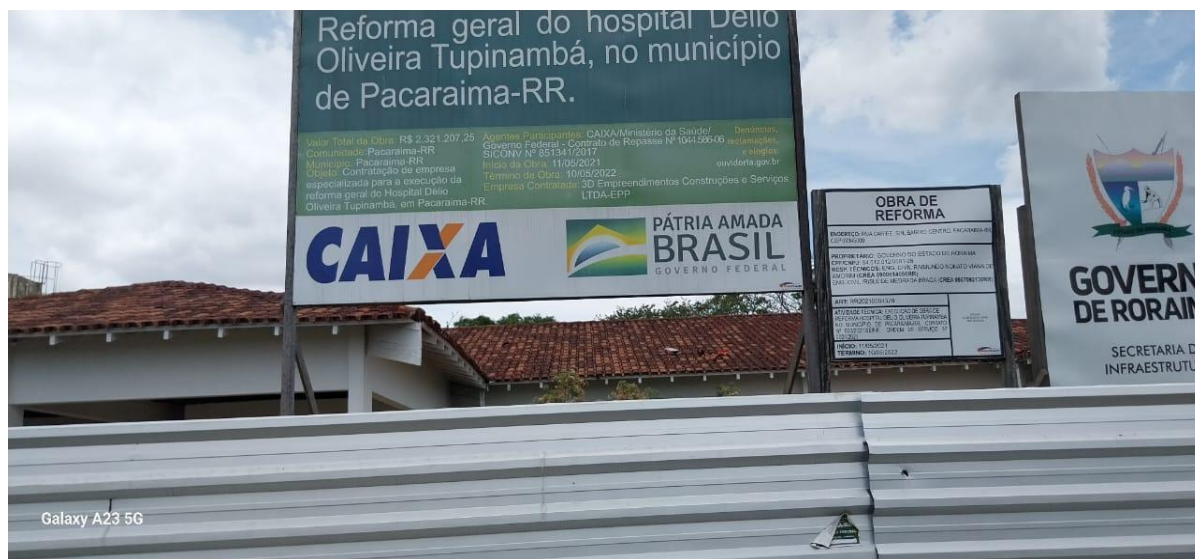
Foto 01- Placa do início da reforma da obra do hospital. Fonte: Autor.
