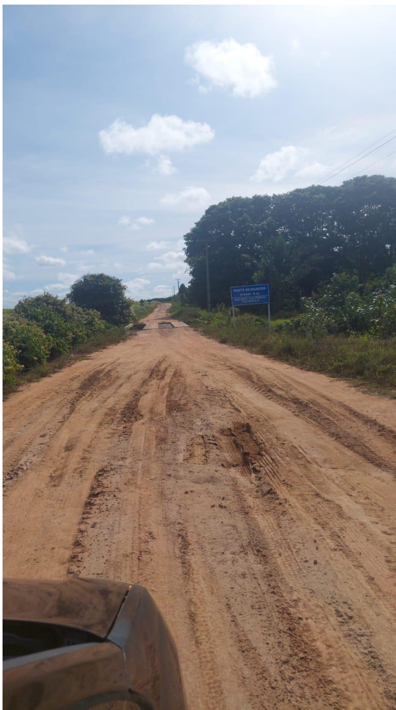
Foto 2: Vicinal fica em área baixa onde no período de chuva fica intransitável. Fonte: Reprodução.
