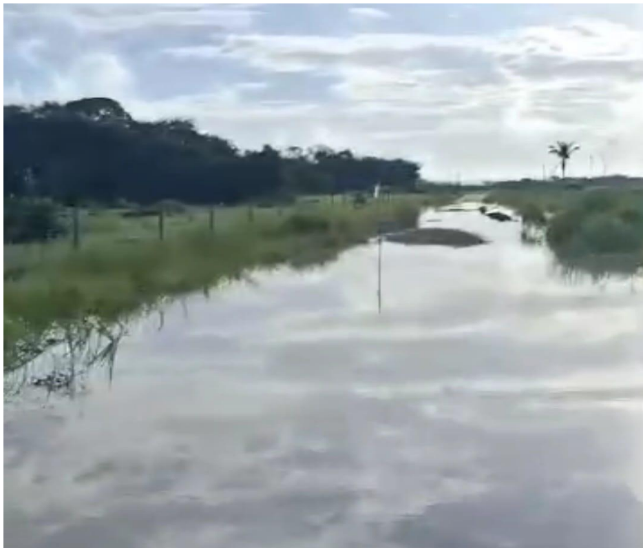
Foto 2: Espaço da vicinal totalmente tomado pela água sem espaço para escoamento Fonte: O mesmo.
