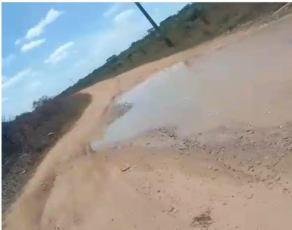
Foto 1: Vicinal com água e pontos de atoleiros sem espaço para escoamento de água. Fonte: O mesmo.
