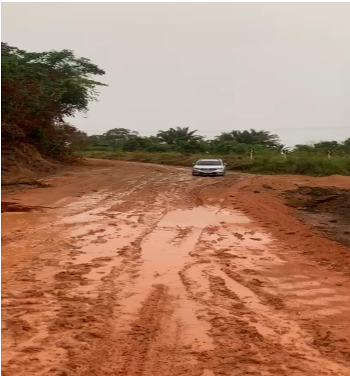
Figura 2: Desvio da estrada intrafegável com lamas e terras escorregadias devido as chuvas; Fonte: o autor.
