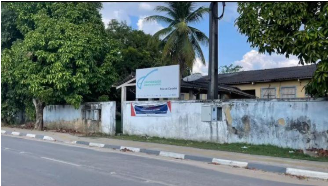
Figura 4: Parte externa da Escola com a pintura desgastada e abandonada; Fonte: @bocadosul_rr.
