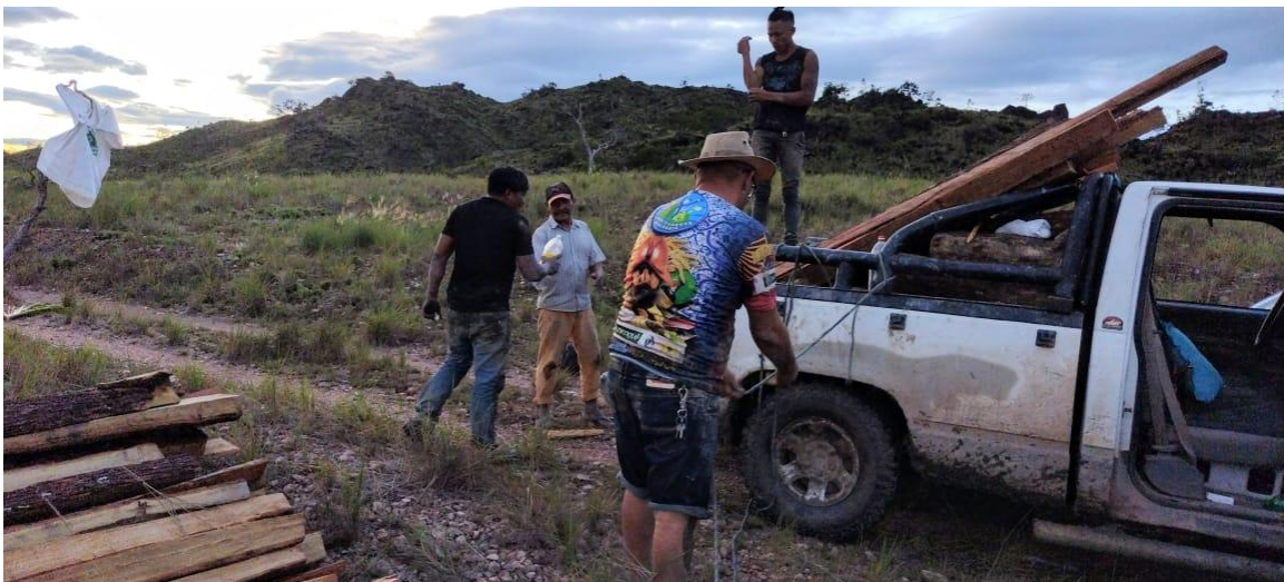
Foto 01. Moradores da Comunidade arrumando a vicinal Fuzuê.
