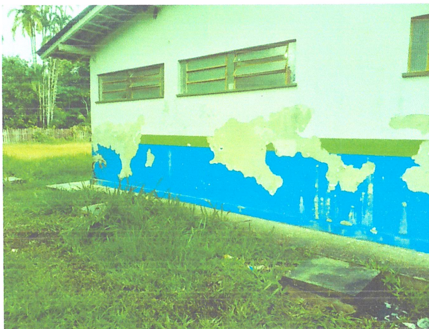
Infiltrações de água nas paredes externas.
