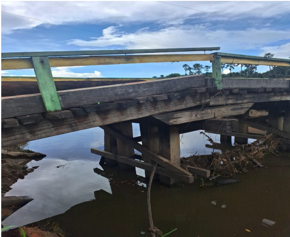
Foto 01 – Vista lateral da ponte.
