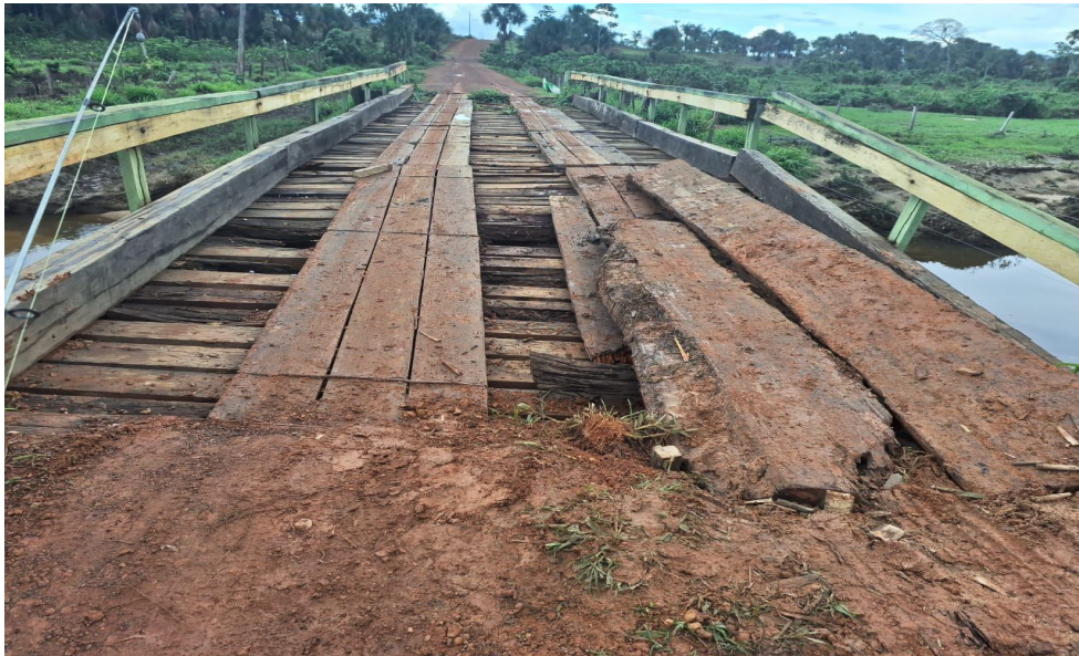
Foto 02 – Vista geral da ponte.
