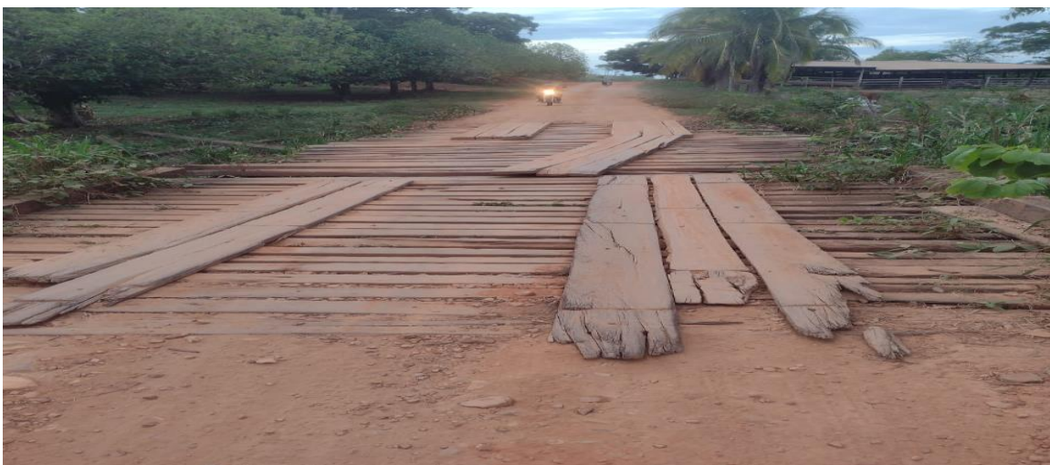
Figura 02: Ponte de madeira com condutor trafegando. (Fonte: Dos Autores 2024)
