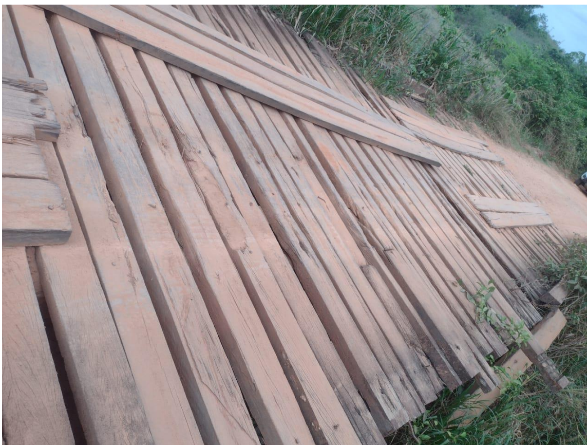
Figura 03: Ponte de madeira na vicinal 6 a cerca de 2km da Vila do Paredão. (Fonte: Dos Autores 2024)
